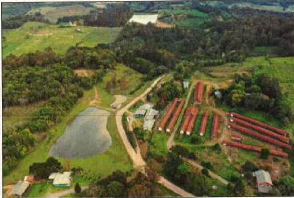
Figura 1: Vista geral da porção sul da propriedade, ao sul da Estr. Júlio de Castilhos.
