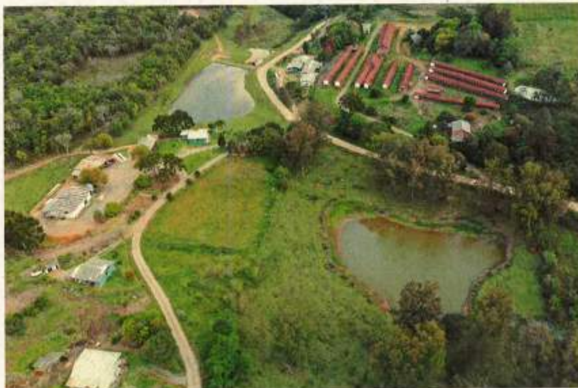
Figura 4- Vista aérea da porção norte da propriedade
