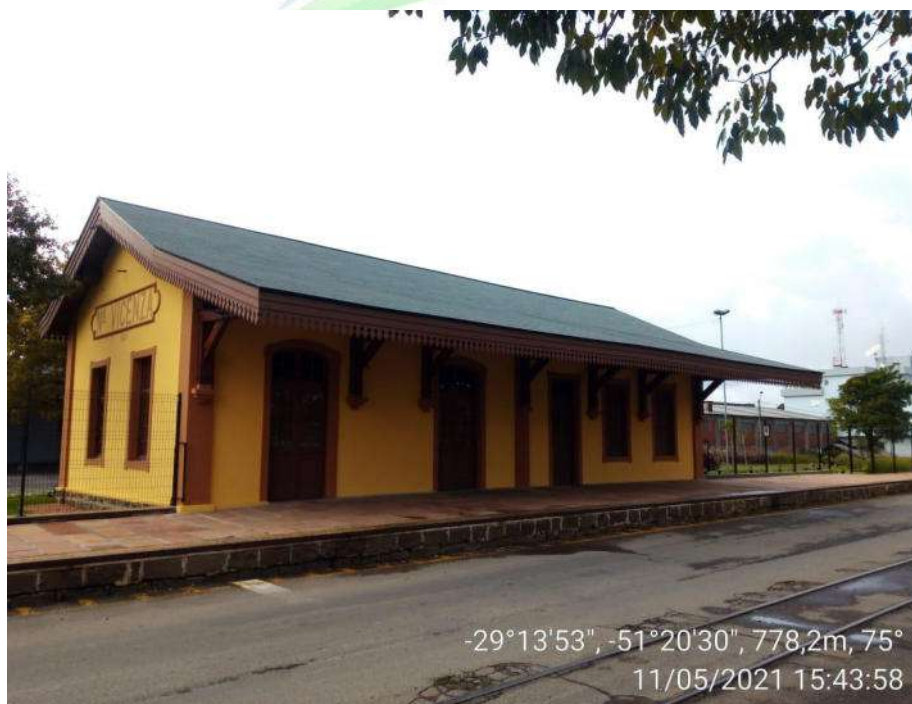
Figura 1 – Vista das fachadas sul e oeste da Estação Férrea Nova Vicenza.
