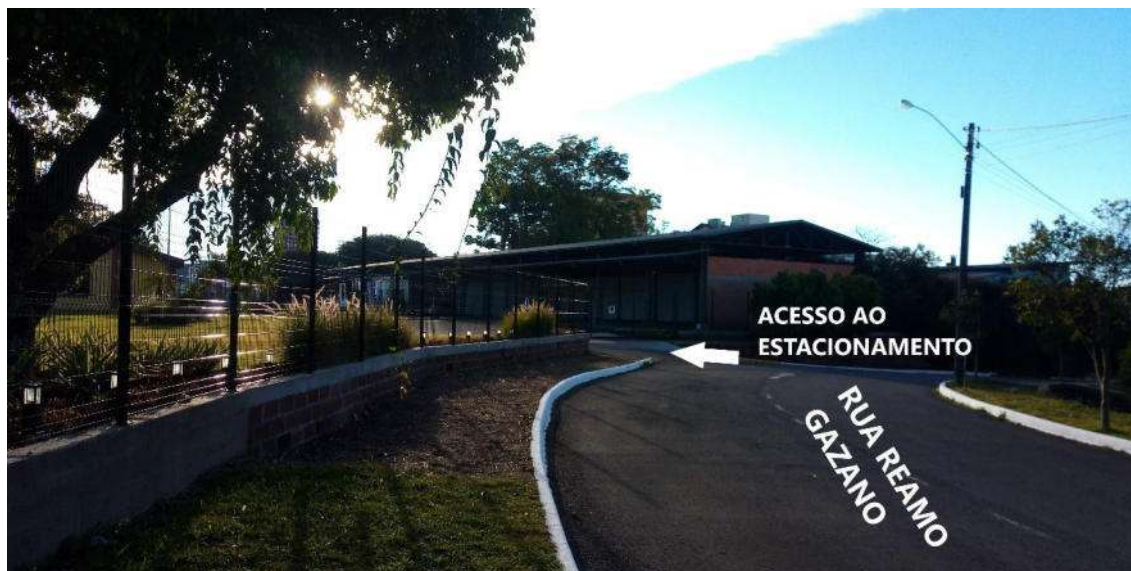
Figura 14 – Vista do acesso ao estacionamento pela Rua Reamo Gazano.
