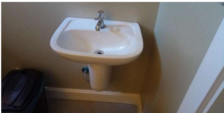
Figura 25 – Lavatório para PNE, com 80 cm de altura.
