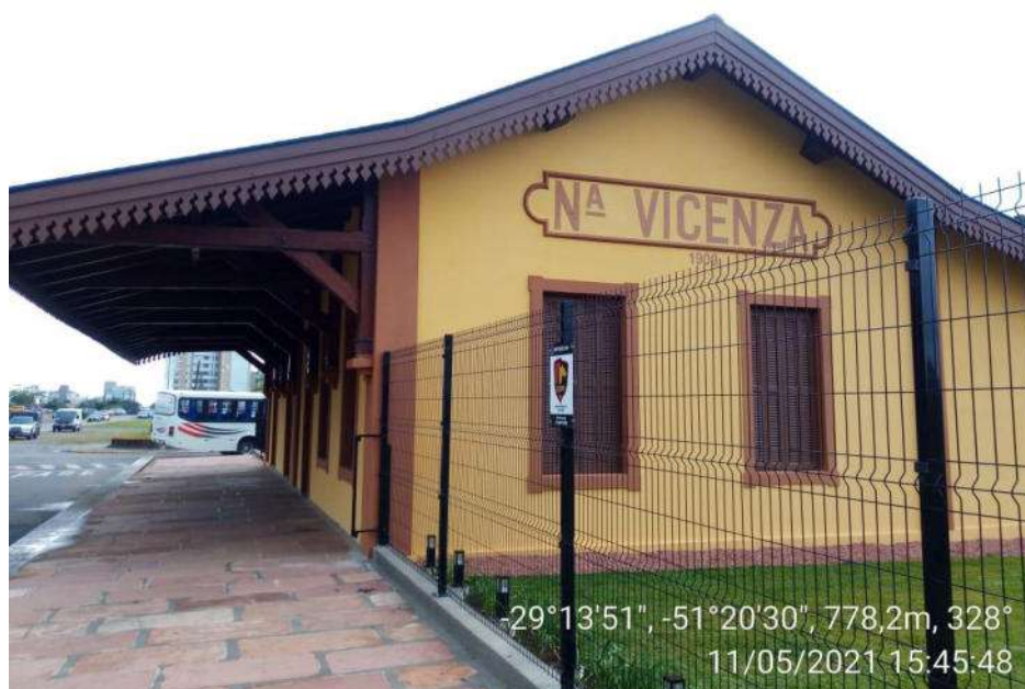
Figura 3 – Vista da fachada leste da edificação.
