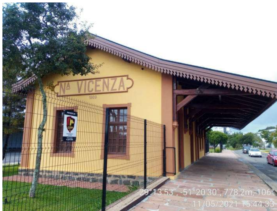
Figura 2 – Vista da fachada oeste da Estação Férrea Nova Vicenza, com a cobertura frontal e cercamento total do terreno da edificação.
