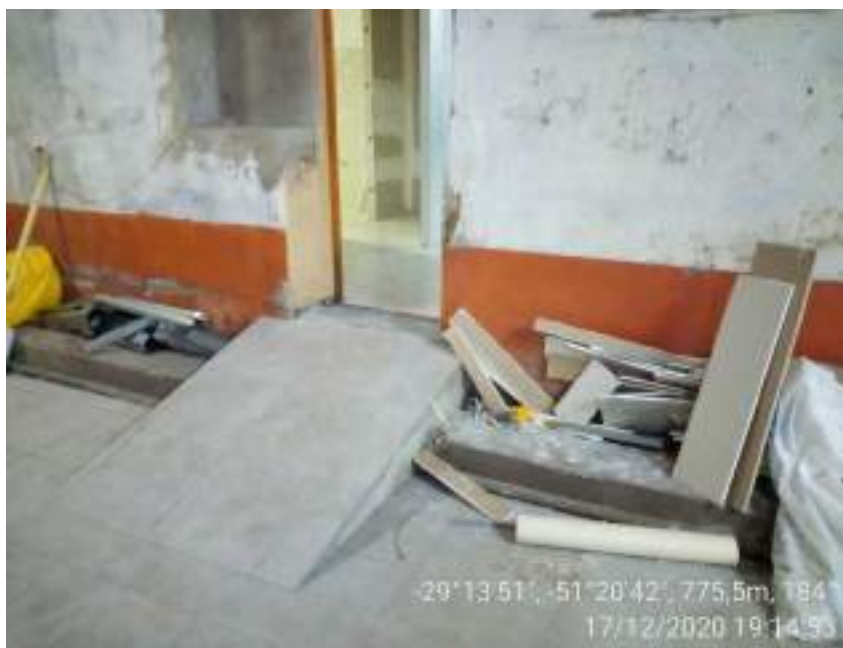
Figura 19 – Rampa de acesso aos banheiros para cadeirantes.
