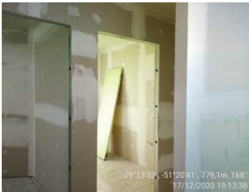
Figura 18 – Construção do banheiro com adaptação para PCD.
