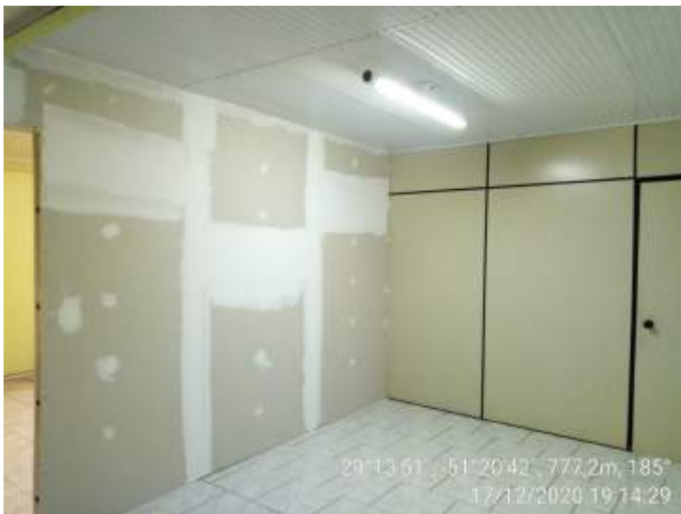
Figura 3 – local onde será instalada a cozinha da cervejaria.
