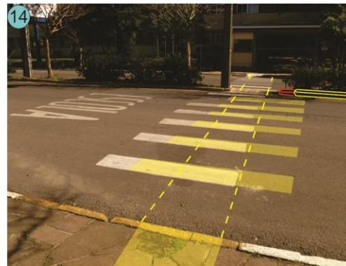
Faixa de pedestres alargada, modificação no canteiro e falta de rampa de acesso para PNEs.
