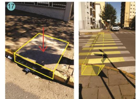
Problemas pontuais de manutenção e falta de rampa para acessar a calçada.
