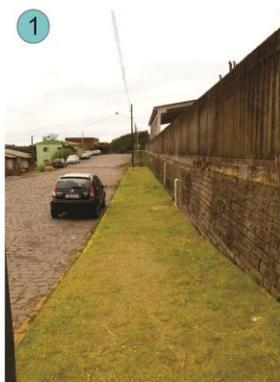
Calçada não pavimentada e sem rampas para acessibilidade dos PNEs.
