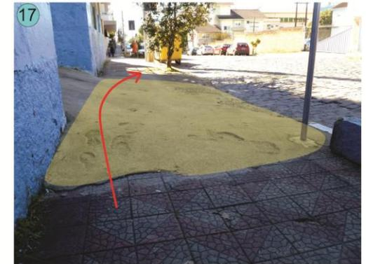
Ponto do passeio com inclinação inadequada do passeio para acesso do estacionamento.
