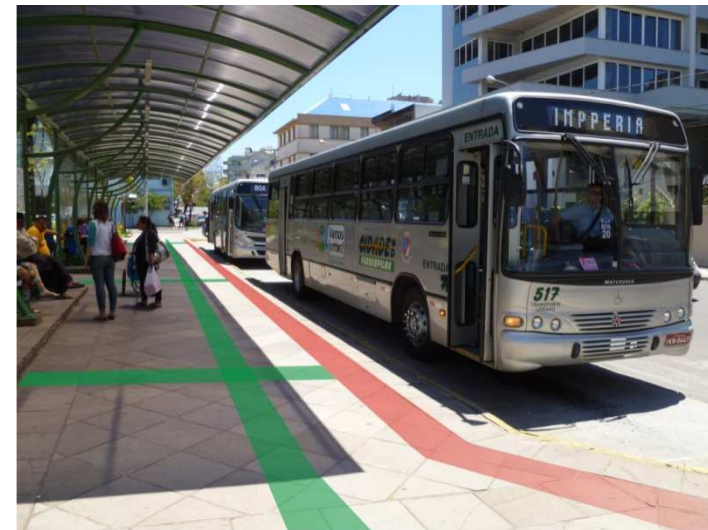
TERMINAL PRAÇA DA MATRIZ COM PROJEÇÃO DE PISOS TÁTEIS
