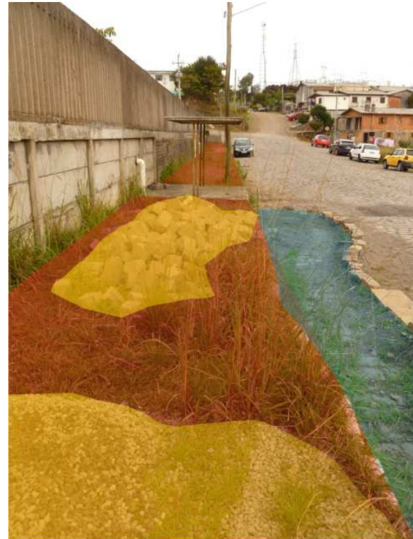
Inadequações em Pontos de ônibus
