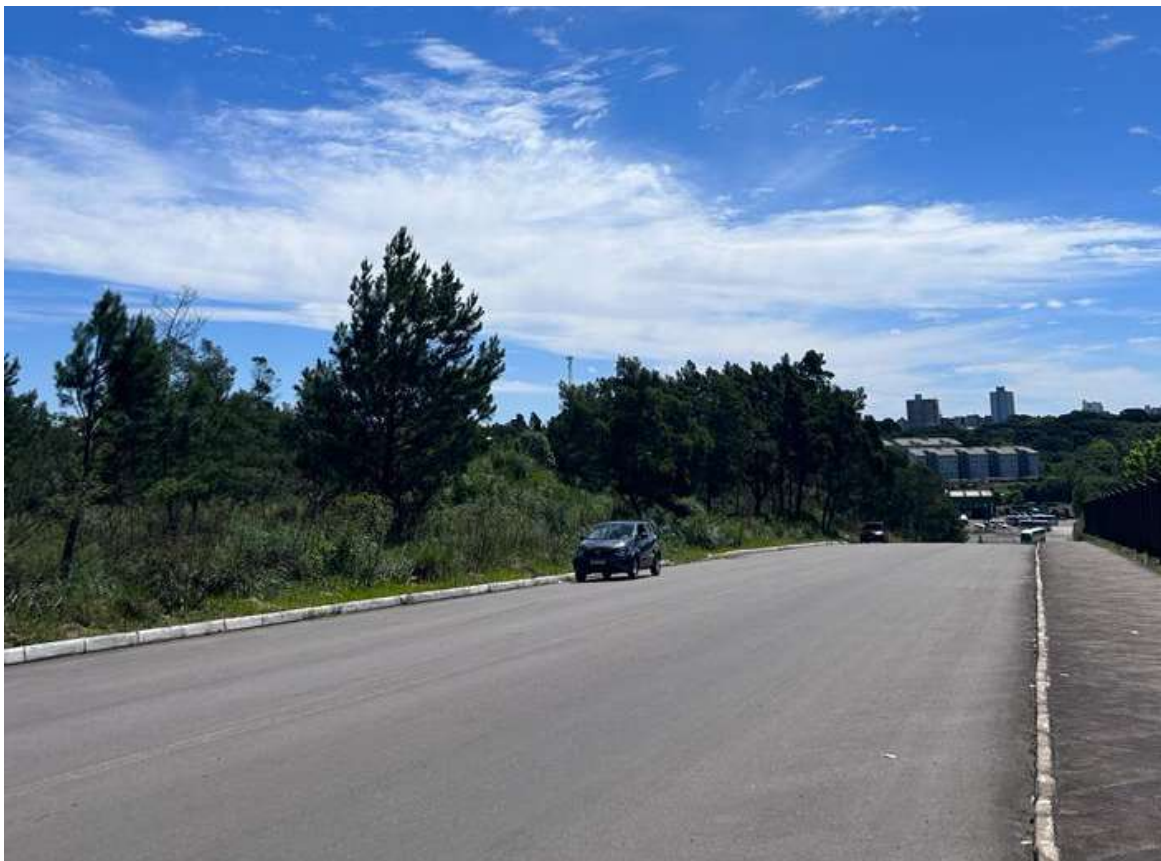
Figura 15: Imagem retiradas pela equipe técnica da Rua Fernando João Bartelle demonstrando a inexistência de iluminação pública.
