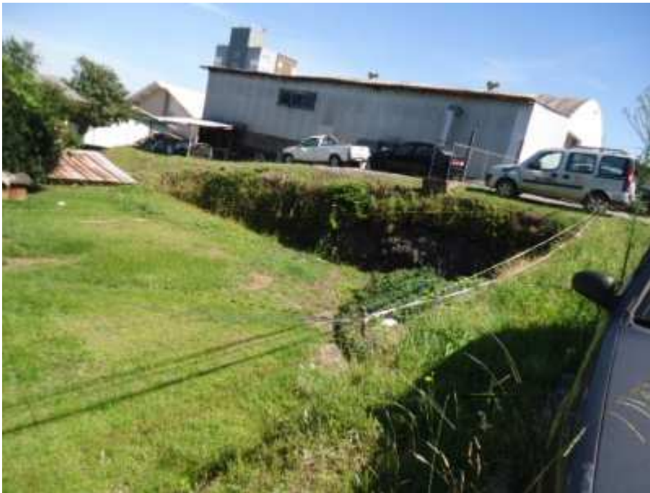
Figura 3 - Vista da área pretendida para construção da estação.
