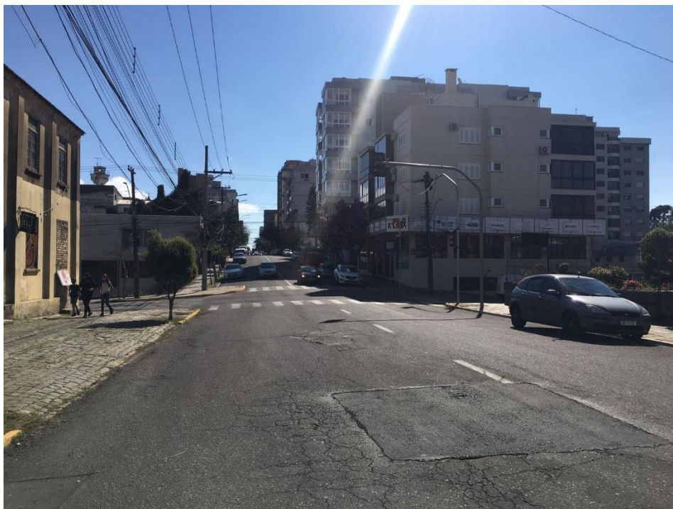
Figura 11. Via Coletora com Revestimento Asfáltico
