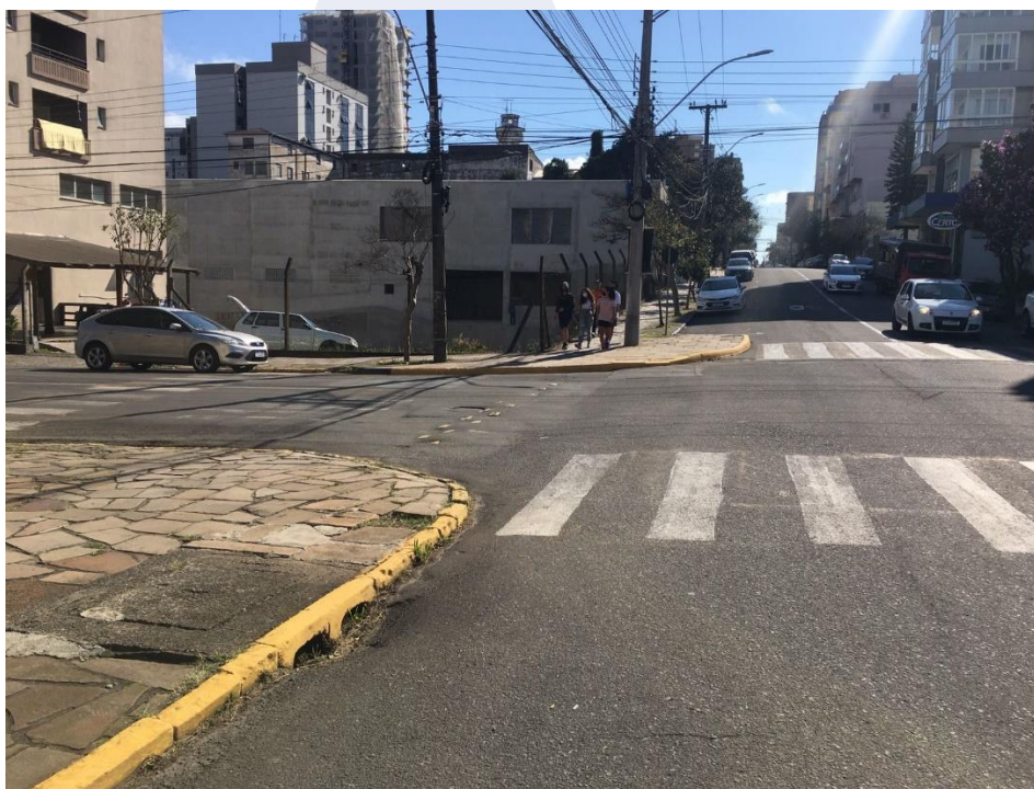
Figuras 13 e 14. Existência de Rede de Águas Pluviais no Local
