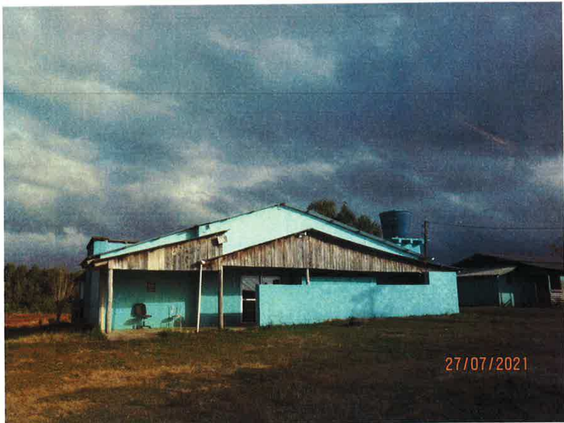
Figura 9 - Edificação presente na área.
