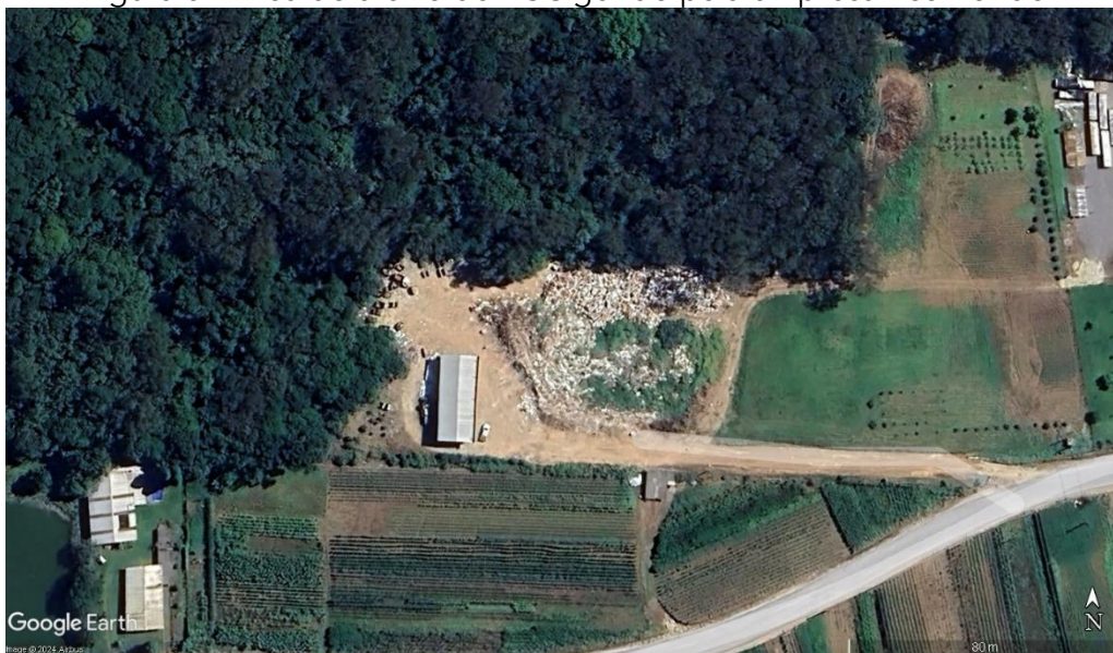
Figura 6 – Área do aterro de RCC gerido pela empresa Ecomondo
