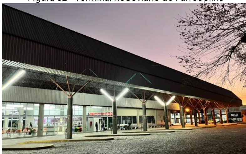
Figura 82 - Terminal Rodoviário de Farroupilha
