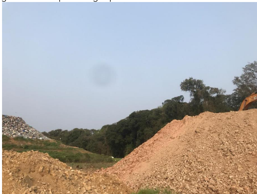
Figura 57 - Estoque de argila para recobrimento dos resíduos
