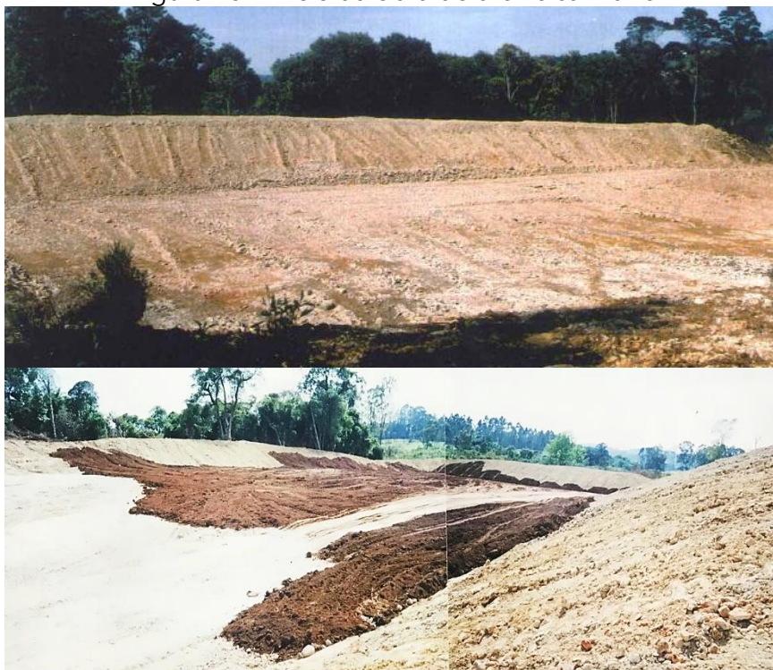
Figura 28 – Início da obra do aterro sanitário
