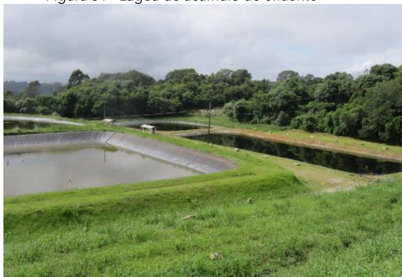
Figura 51 - Lagoa de acúmulo de efluente
