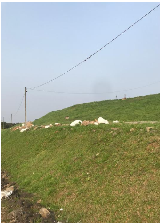
Figura 49 - Células encerradas do aterro sanitário de Farroupilha
